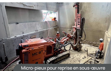
Micro-pieux pour reprise en sous-œuvre
