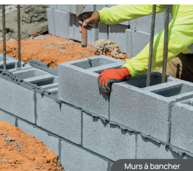
Murs à bancher
