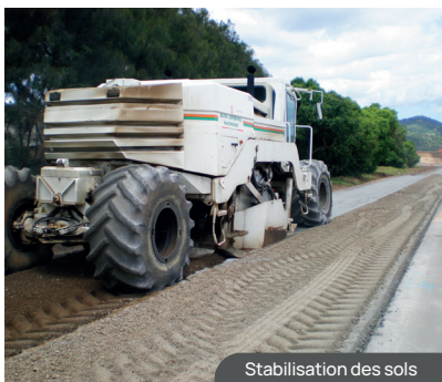
Stabilisation des sols
